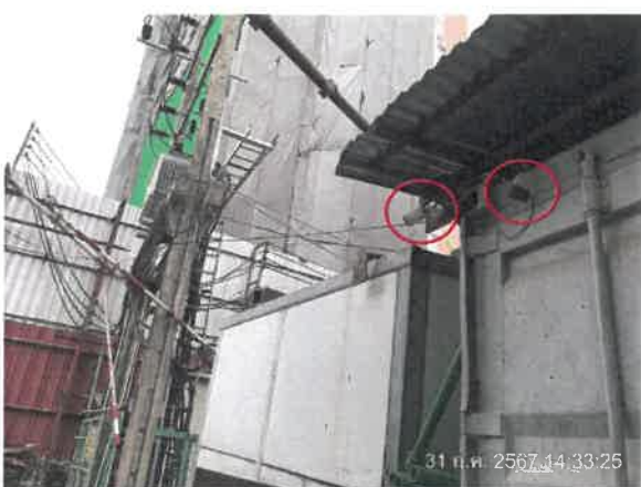
รูปที่ 2-63 แสดงการติดตั้งกล้องวงจรปิดภายในพื้นที่ก่อสร้าง
