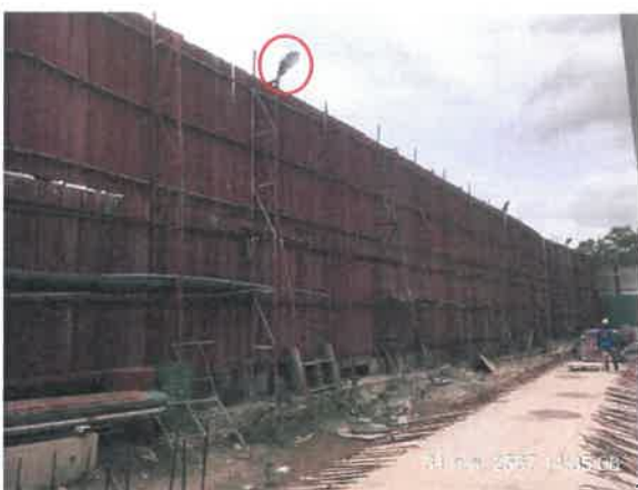
รูปที่ 2-9 แสดงการติดตั้งไฟสปอตไลท์ไว้ตามรั้วเมทัลชีท (Metal Sheet) ภายในพื้นที่ก่อสร้าง
