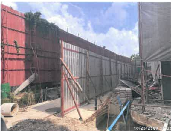
รูปที่ 2-2 แสดงรั้วทึบเมทัลชีท (Metal Sheet) รอบพื้นที่ก่อสร้าง
