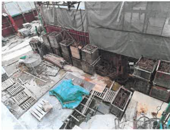
รูปที่ 2-18 แสดงพื้นที่สำหรับเก็บกองวัสดุก่อสร้าง และกล่องที่ปิดล้อมทั้ง 4 ด้าน ไว้สำหรับเก็บเศษวัสดุก่อสร้าง
