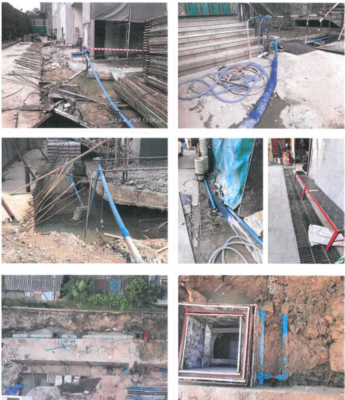
รูปที่ 2-5 แสดงรายละเอียดน้ำชั่วคราว พร้อมทั้งติดตั้งท่อระบายน้ำ
