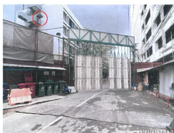
รูปที่ 2-9 แสดงการติดตั้งไฟสปอตไลท์ไว้ตามรั้วเมทัลชีท (Metal Sheet) ภายในพื้นที่ก่อสร้าง
