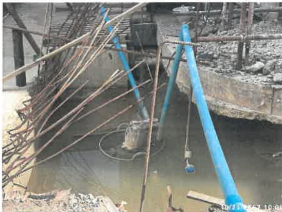
รูปที่ 2-15 แสดงเครื่องสูบน้ำ
