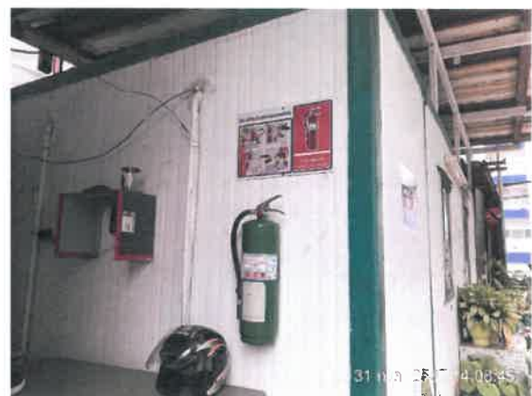
รูปที่ 2-73 แสดงถังดับเพลิงชนิดผงเคมีแห้ง พร้อมป้ายแนะนำการใช้งาน
