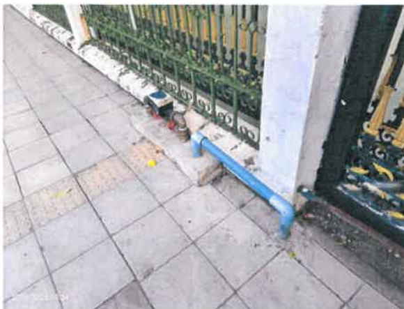
รูปที่ 2-39 แสดงติดตั้งมิเตอร์รับน้ำและระบบท่อประปาเชื่อมต่อกับท่อประปาของสำนักงานประปานครหลวง
