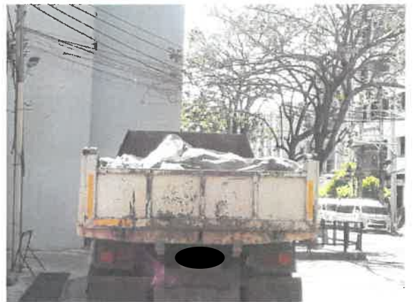
รูปที่ 2-20 แสดงผ้าใบที่ปิดคลุมท้ายรถบรรทุกขนดินและวัสดุก่อสร้าง
