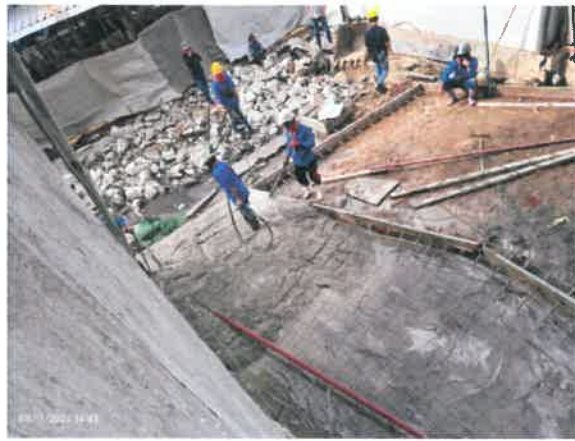
รูปที่ 2-67 แสดงการใช้เครื่องจี้ปูนไฟฟ้า
