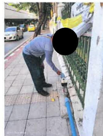
รูปที่ 2-39 แสดงติดตั้งมิเตอร์รับน้ำและระบบท่อประปาเชื่อมต่อกับท่อประปาของสำนักงานประปานครหลวง
