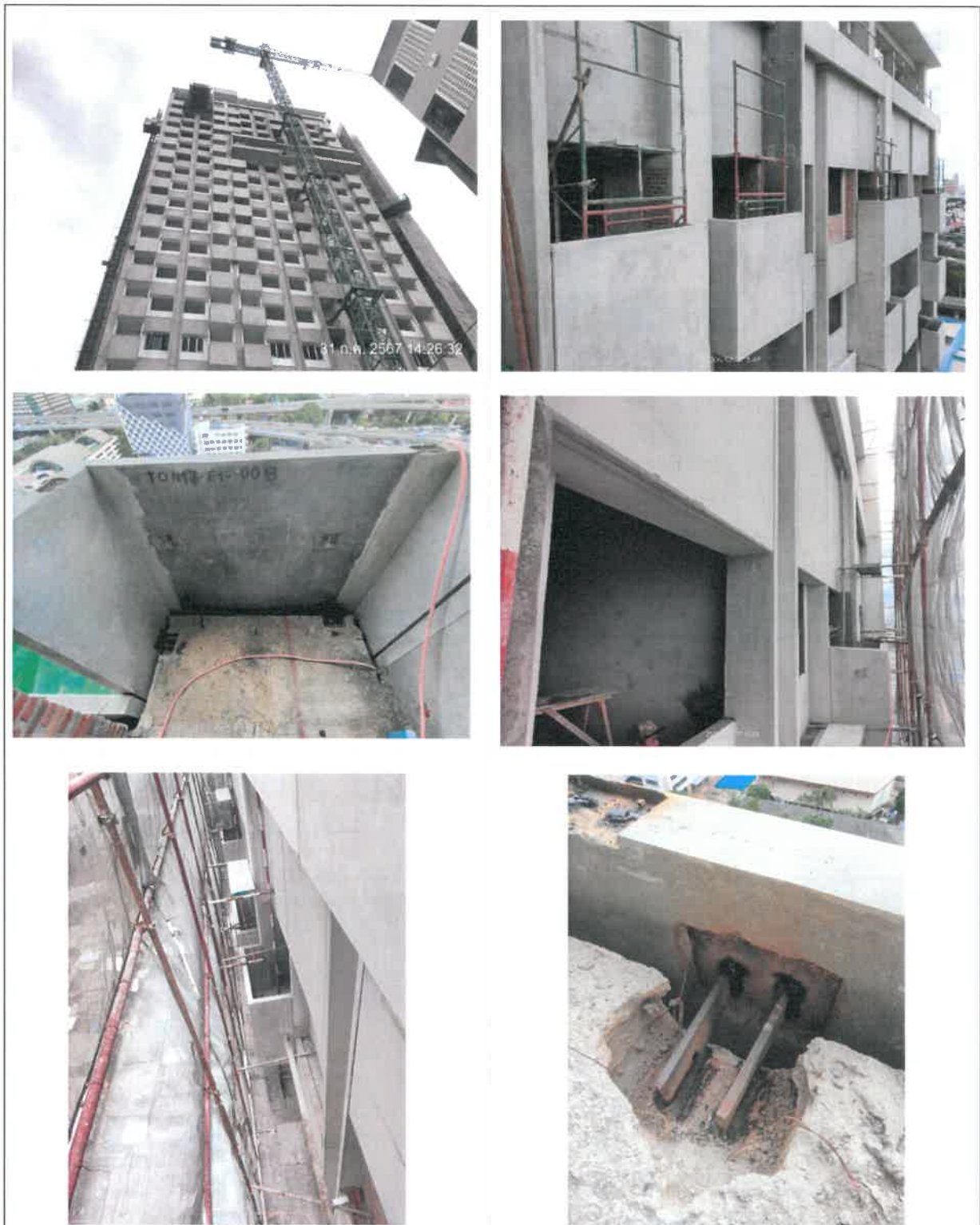
รูปที่ 2-27 แสดงการใช้ผนังคอนกรีตสำเร็จรูป (Precast Concrete)
